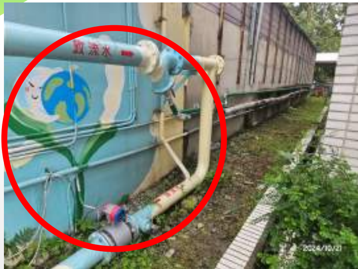
新設回收水管
